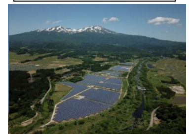
庄内・遊佐太陽光発電所
